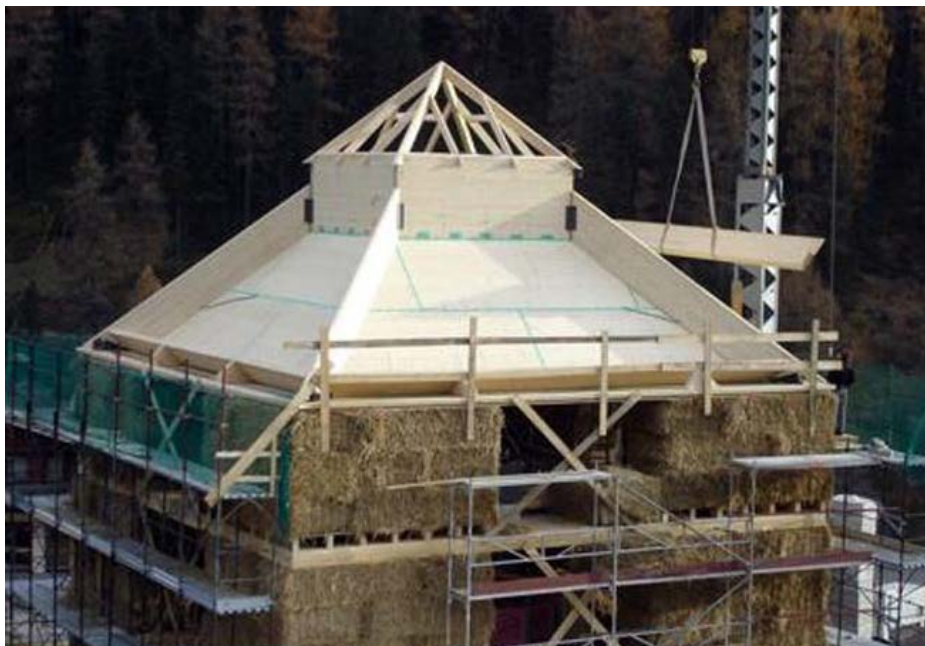
Edificio multipiano realizzato con struttura portante in legno e tamponamenti in balle di paglia (fonte: ladomenicadivicenza.gruppovideomedia.it )
