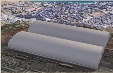
Capannoni chiusi e automatizzati per minerale ferroso, carbone e coke, agglomerato, omogeneizzato
