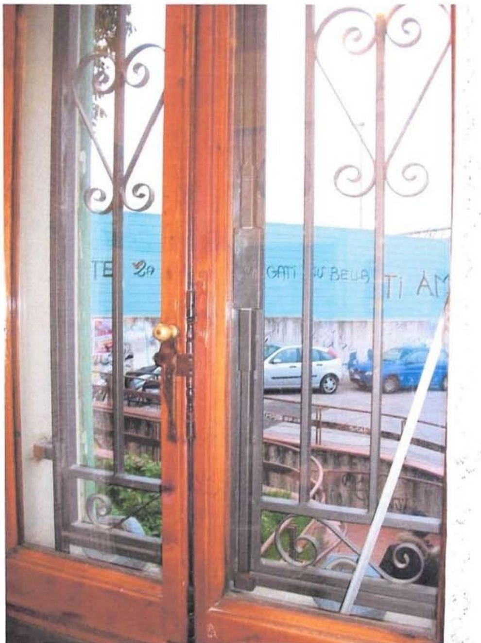
27) Vista da una delle finestre dei vani sul 'logistico.
