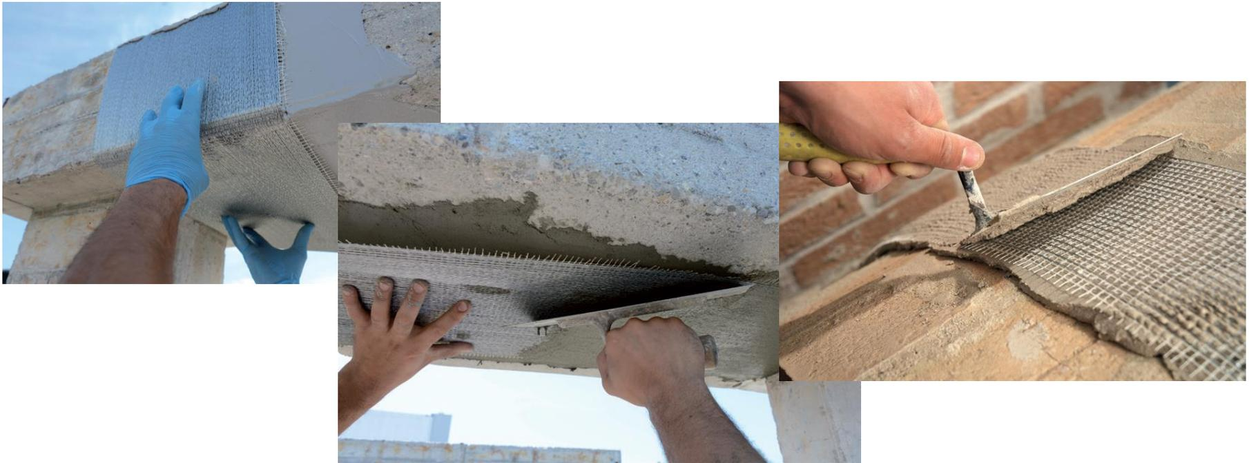
Rinforzo di strutture esistenti in c.a., c.a.p., muratura e legno con sistemi compositi realizzati in sito tramite placaggio esterno
