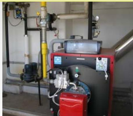
Caldaia a condensazione centralizzata per riscaldamento e produzione ACS
