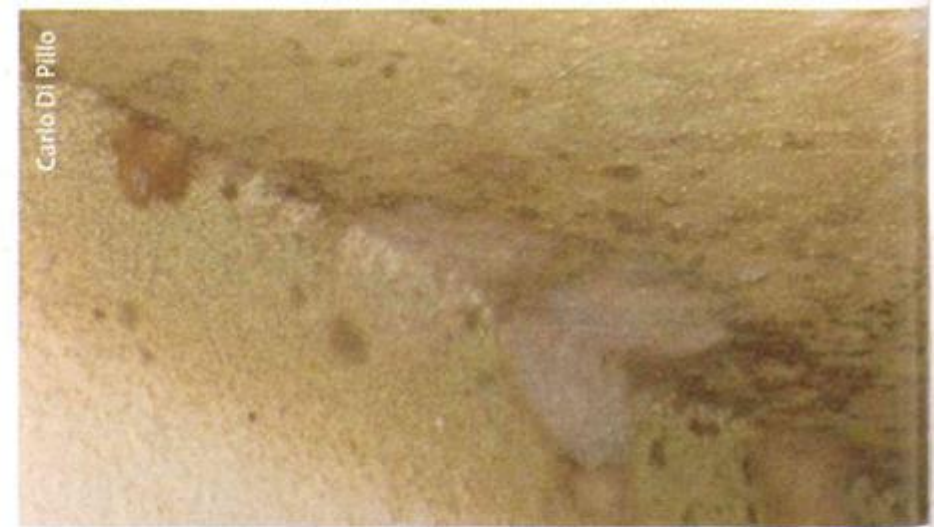
Foto di muffe sviluppatesi lungo un ponte termico: si noti la linea di arresto della crescita in basso a sinistra.
