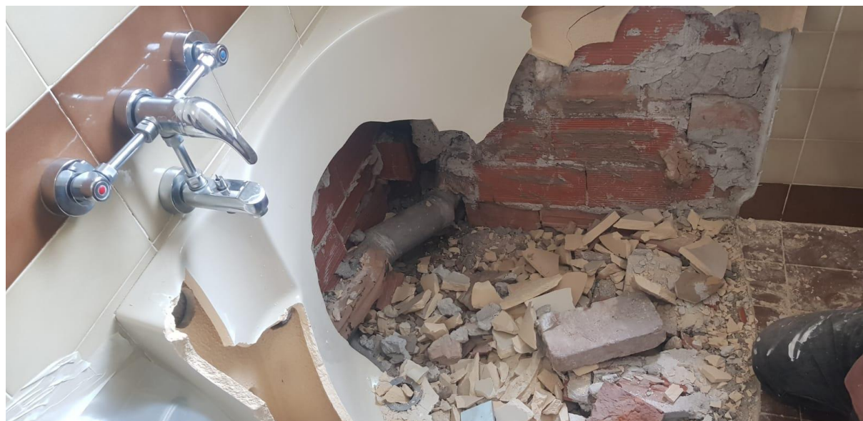
3/1/2020 La tubazione di scarico rotta
