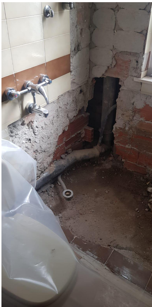
3/1/2020 La tubazione di scarico rotta
