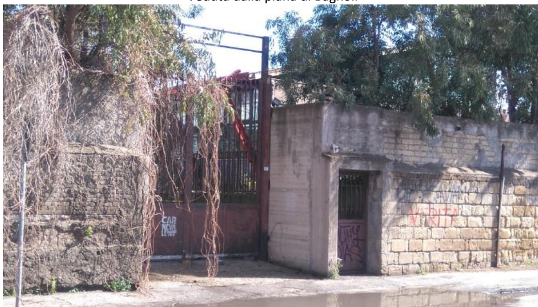
Ingresso da Via Coroglio
