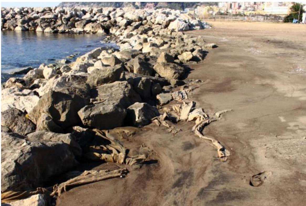
Particolare degli ancoraggi del telo TNT
