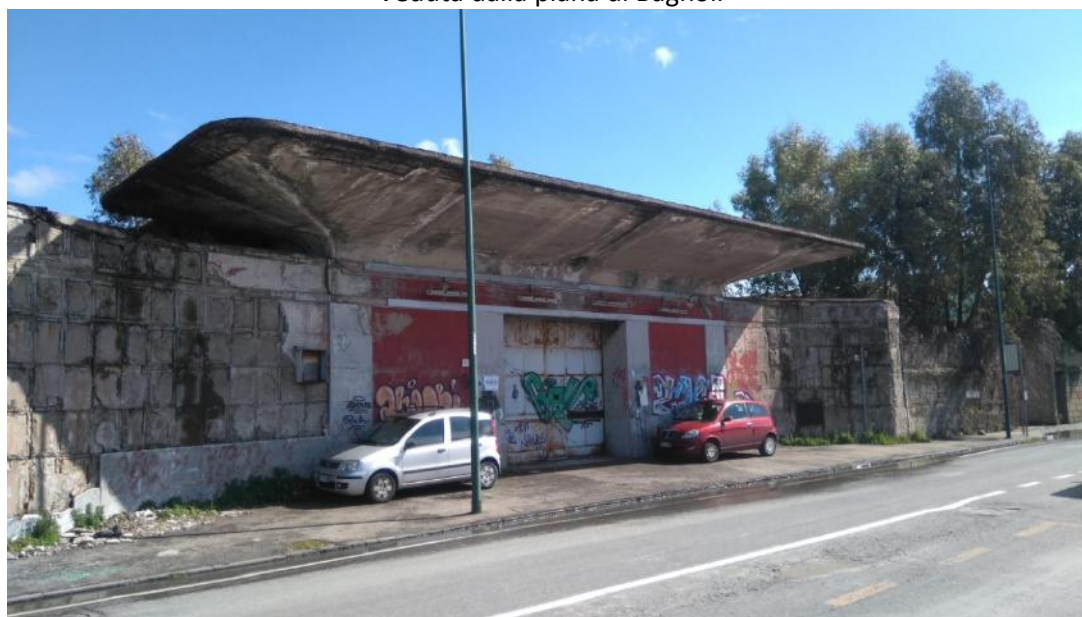
Ingresso da Via Coroglio
