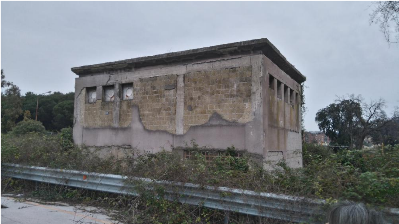
Vista da Via Cocchia
