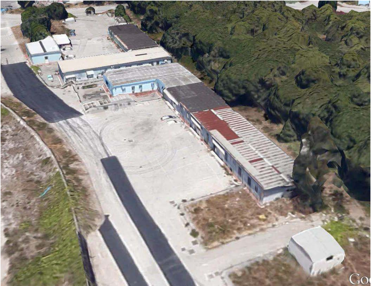
Vista da Via Cocchia
