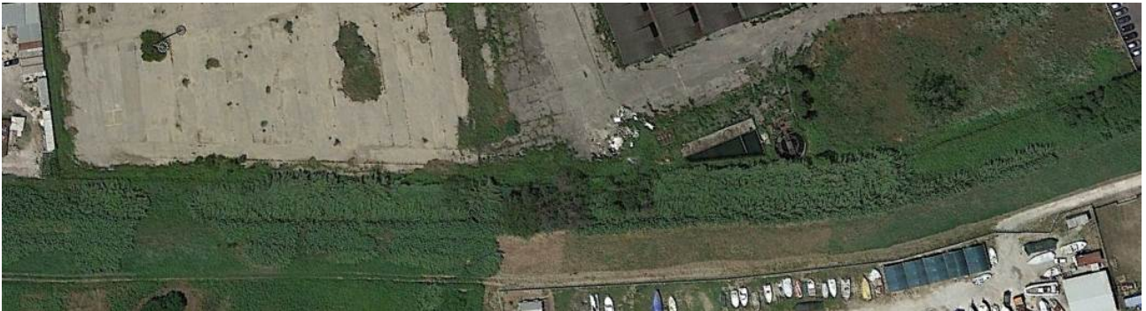
Figura 14.5 – La parte finale dell'accesso al cantiere operativo del Ponte dei Congressi in destra idrografica attraverso il Lungotevere della Magliana
