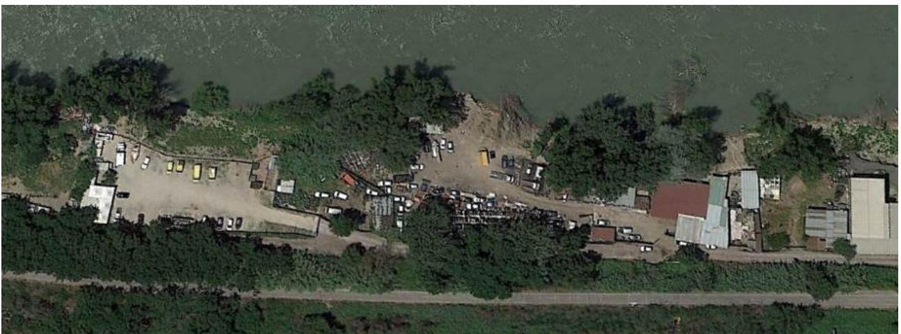
Figura 14.3 – L'accesso al cantiere operativo del Ponte dei Congressi in sinistra idrografica lungo Via del Cappellaccio
