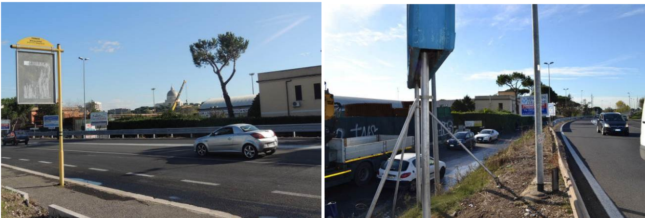
Figura 14.2 – Punti di lavorazione nell'ambito del cantiere lineare per le pile delle rampe di svincolo dalla Roma Fiumicino sul Ponte dei Congressi
