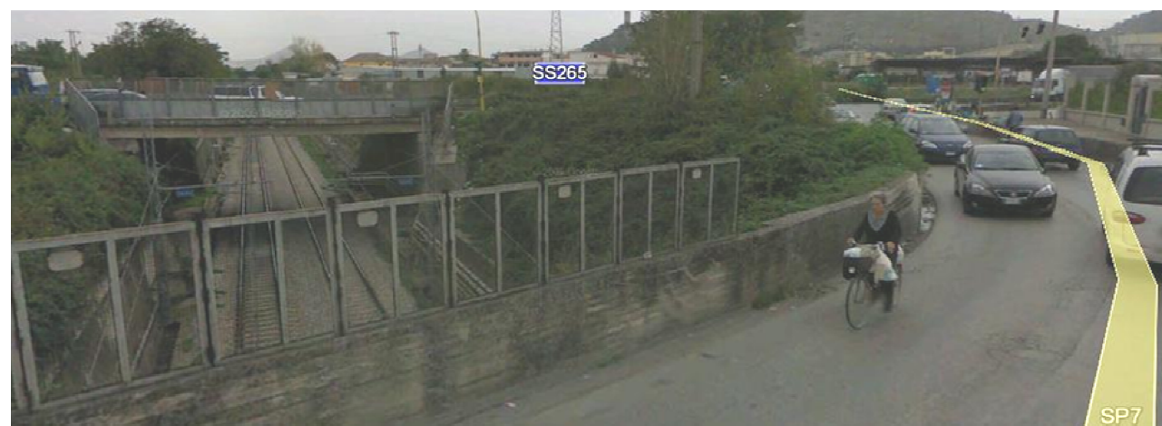
Foto 18 – Cavalcaferrovia esistente della SP7- al Km 222+801 della l.s.- (nuova pk 3+382)
