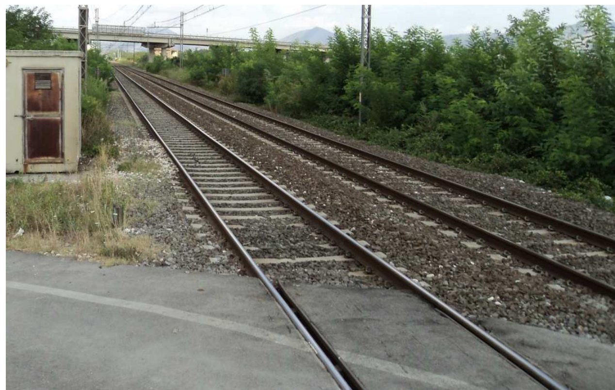
Foto 5 - PL al Km 219+319 della linea storica con vista del cavalcaferrovia su SS265
