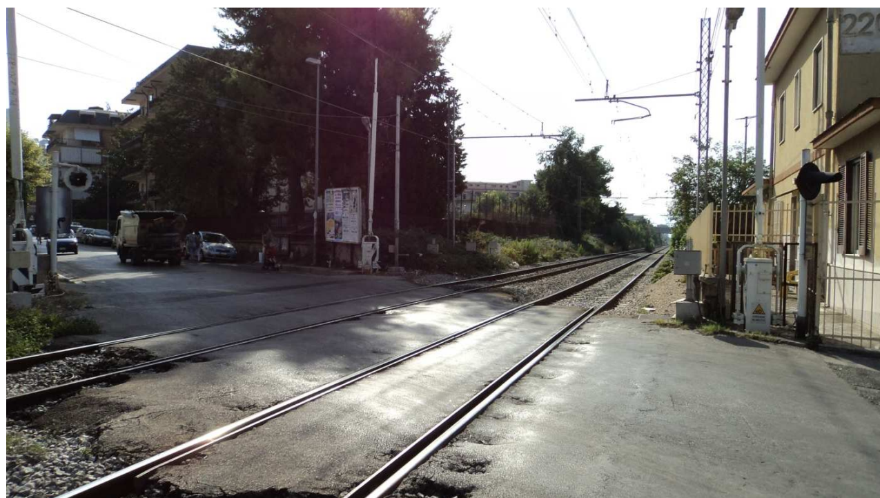
Foto 7 – PL di Via Appia al Km 220+821 della linea storica – (nuova pk 1+400)
