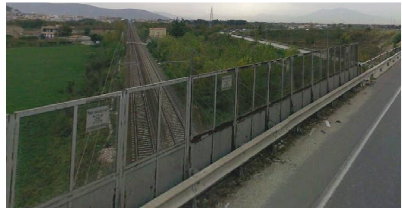
Foto 12 – Cavalcaferrovia esistente per SS265 – al Km 219+127 della linea storica
