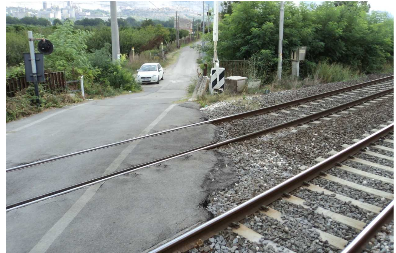
Foto 6 - PL al Km 219+319 della linea storica con vista lato nord
