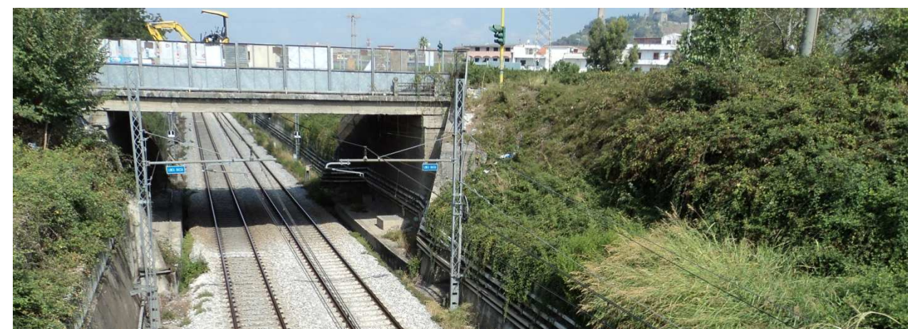
Foto 17 – Cavalcaferrovia esistente della SS265- al Km 222+754 della linea storica
