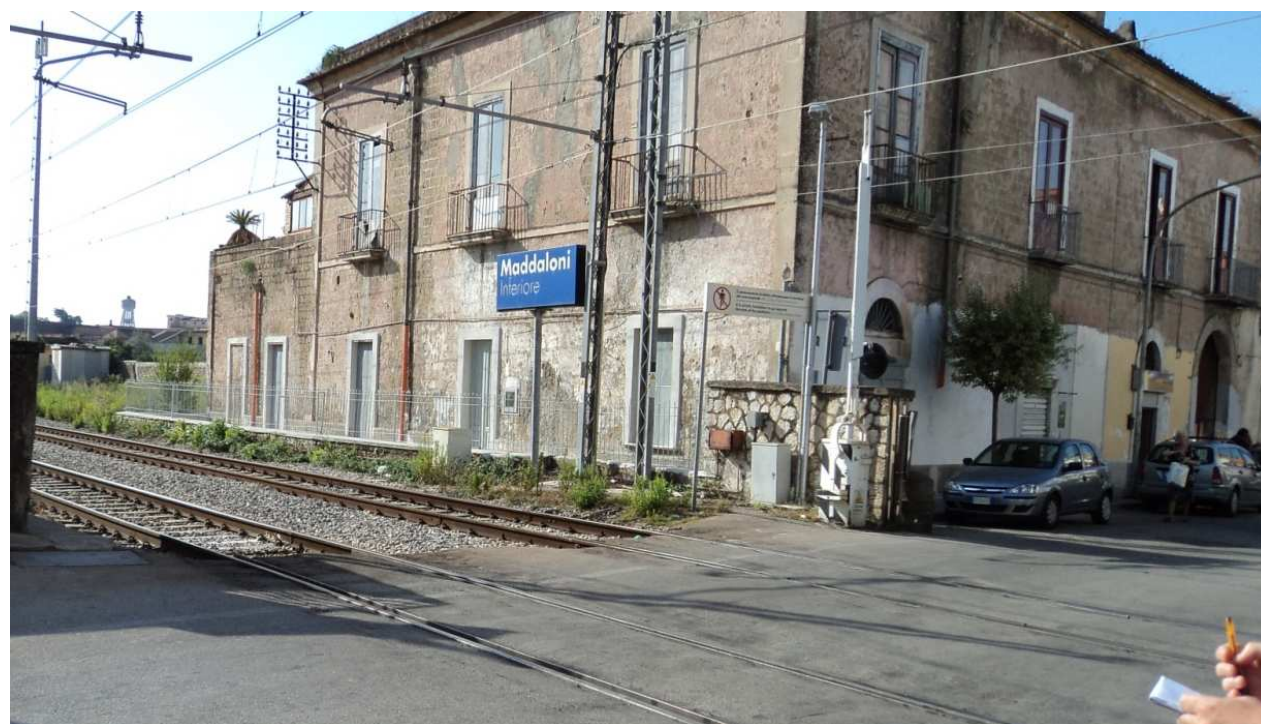
Foto 9 – PL Via Napoli (stazione Maddaloni Inferiore) al Km 221+472 della linea storica
