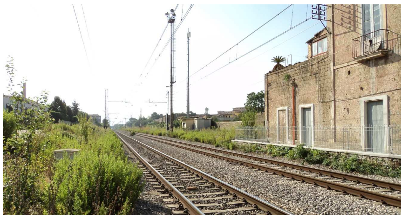
Foto 2 – Soluzione 1 – Zona individuata per la posizione della futura fermata interrata Vista dal passaggio a livello di via Napoli
