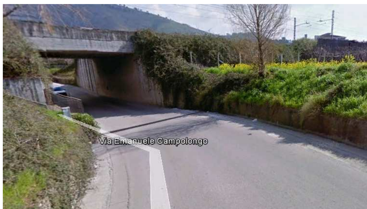
Foto 13 – Sottovia – Via E. Campolongo al Km 220+320 della linea storica
