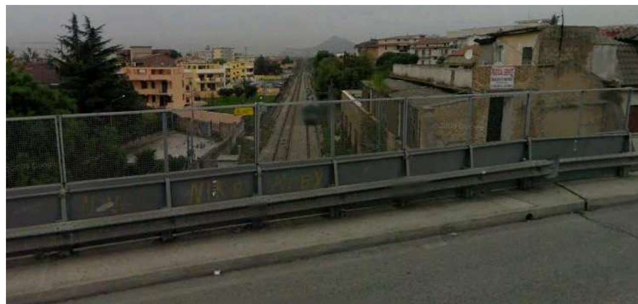
Foto 15 – Cavalcaferrovia a via Libertà, al Km 221+220 della linea storica: vista dall'impalcato lato Caserta
