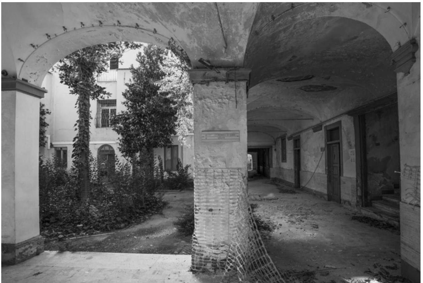
Vista interna del chiostro dell'Ex Convento di Sant'Agata / Inside view of San'Agata Convent
