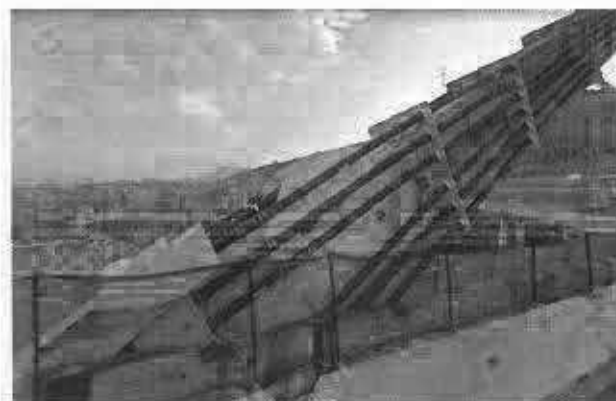
Figura 6: intervento di consolidamento degli stralli della pila 11
