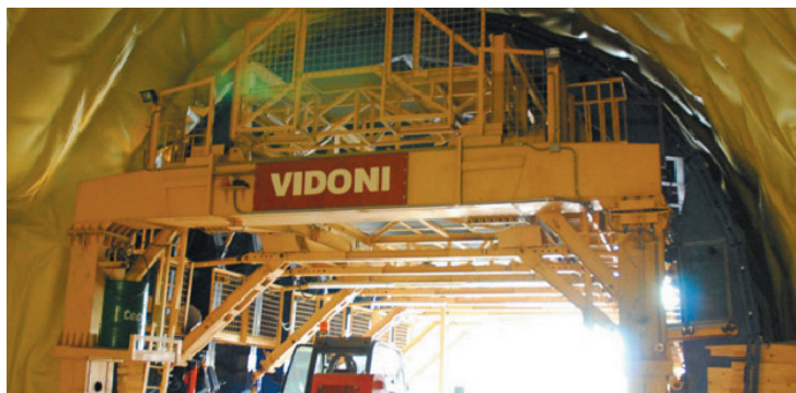
La Vidoni al lavoro sulla galleria per l'autostrada Gorizia Lubiana
