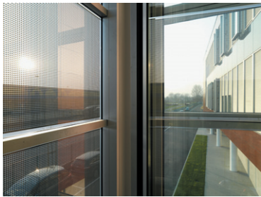
■ La finestra fotovoltaica automatizzata che produce energia elettrica tramite vetrocamera fotovoltaico semitrasparente
