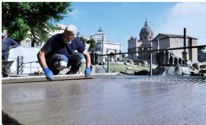
Fig. 20 - Messa in opera della struttura tridimensionale a celle concatenate semi rigida riempita dal terreno battuto. D.L.G. Strano, progetto M.G. Filetici, assistenza M. Talani, P. Piazzolla, 2021. Fig. 21 - Fase della messa in opera dei battuti nell'ambito del progetto PERCORSI, area del Tempio di Vesta nel Foro romano. Progetto M.G. Filetici assistenza tecnica M. Talani, amministrativa P. Piazzolla, 2021. -Credits: Archivio autrice.
