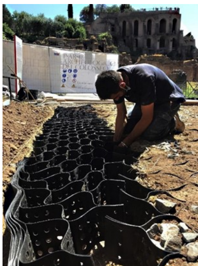
Fig. 20 - Messa in opera della struttura tridimensionale a celle concatenate semi rigida riempita dal terreno battuto. D.L.G. Strano, progetto M.G. Filetici, assistenza M. Talani, P. Piazzolla, 2021. Fig. 21 - Fase della messa in opera dei battuti nell'ambito del progetto PERCORSI, area del Tempio di Vesta nel Foro romano. Progetto M.G. Filetici assistenza tecnica M. Talani, amministrativa P. Piazzolla, 2021. -Credits: Archivio autrice.
