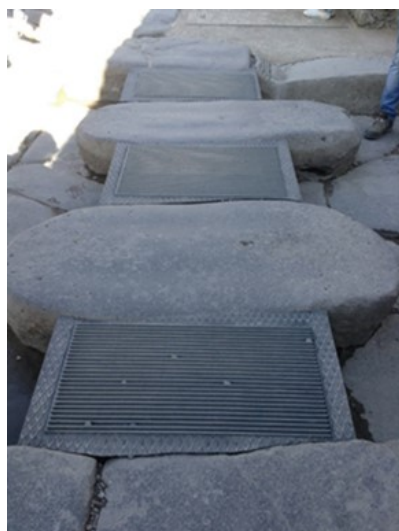
Figg.3,4,5,6 – Pompei. "Pompei per tutti" è il progetto realizzato lungo via dell'Abbondanza. Per superare le barriere per l'attraversamento della strada basolata costituite da passaggi inaccessibili di basoli in rilievo, abbiamo creato attraversamenti accessibili integrando i vuoti con elementi in acciaio reversibili utili alla continuità del percorso di visita accessibile. I percorsi sono stati restaurati rendendo uniforme il piano di calpestio con battuti tradizionali con materiali di cromia e granulometria diverse. Disegno Invitalia B. Rubichi, M.R. Acetoso, progetto M.G. Filetici, L. Scaroina MiC, D.L. G.Vitagliano. - Credits: Archivio autrice.
