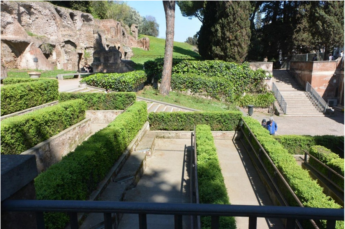
Fig. 2 – Roma. Ingresso al Parco del Colosseo, dal portale del Vignola dove si è modificata la precedente aiuola realizzando una nuova rampa a norma scandita da siepi in bosso. Progetto M.G. Filetici 2016 con G. Cetorelli MiC, rilievi e disegni di dettaglio P. Brunori. -Credits: Foto archivio autrice.
