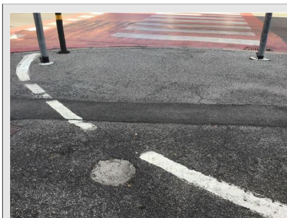
Via Marzabotto – dettaglio separazione pista ciclabile e percorso pedonale
