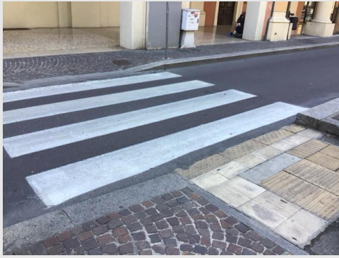
Via Guglielmo Marconi – fermata del bus/filobus con segnaletica podotattile di orientamento inadeguata posta, in corrispondenza dell'attraversamento pedonale, solo sulla pensilina, non nel marciapiede
