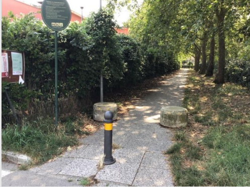
Giardino Omero Schiassi – ingresso con pendenza eccessiva, sconnessioni e palina dissuasore che riduce la larghezza
