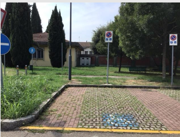
Via Marco Emilio Lepido – parcheggio con pavimentazione adeguata ma privo di raccordo con sede pedonale
