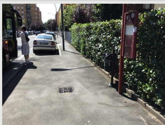
Via Ermete Zacconi – fermata con "golfo" adeguata, con altezza insufficiente e priva di pensilina di protezione e sedute
