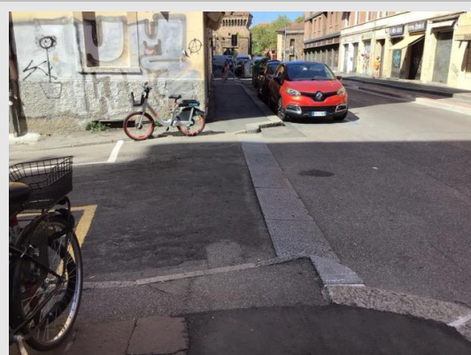
Via San Donato – mobilità nel percorso/attraversamento pedonale ostacolata da bici a noleggio in sosta vietata
