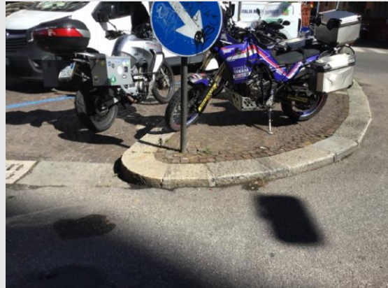
Via Riva di Reno – realizzazione di attraversamento pedonale protetto tra marciapiede e area parcheggio
