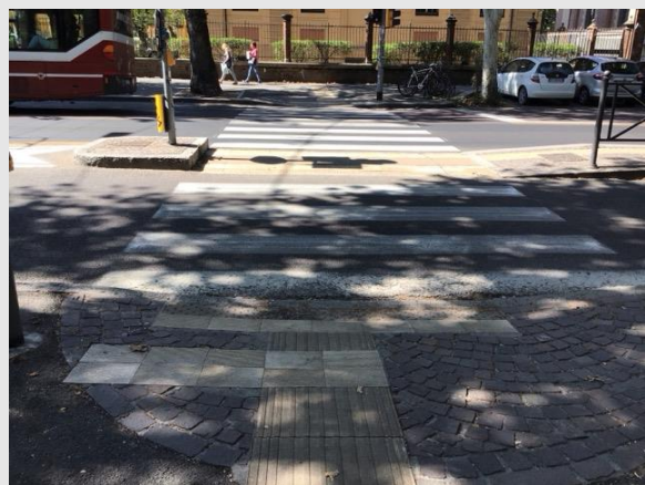
Via Irnerio – rampa con conformazione inadeguata e segnaletica podotattile con elementi che creano confusione
