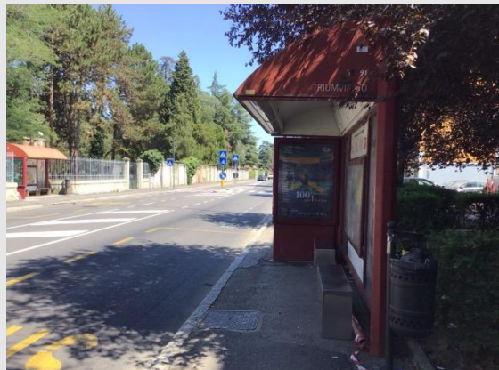
Via del Triumvirato – pensilina del bus che occupa parte del percorso pedonale, restringendolo ad una larghezza inferiore ai 90 cm
