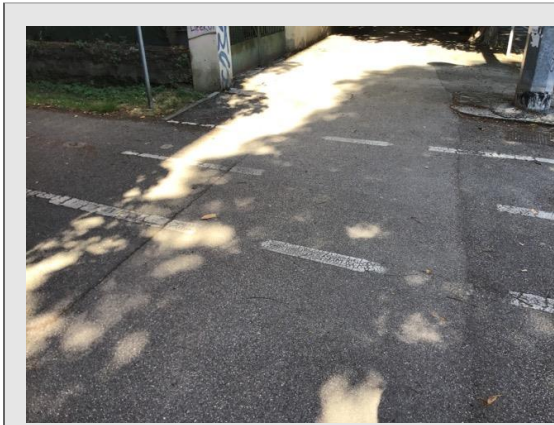
Via Donato Creti – attraversamento ciclabile su percorso pedonale
