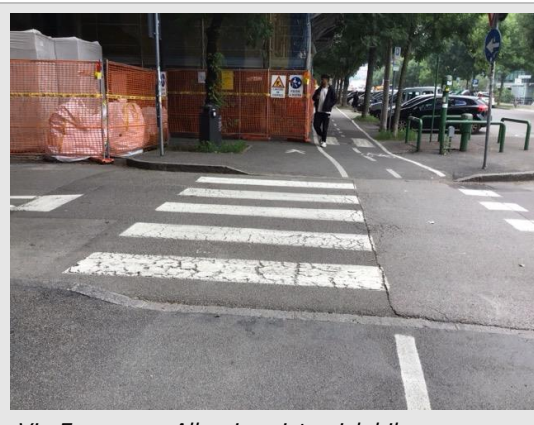
Via Francesco Albani – pista ciclabile e percorso pedonali promiscui non segnalati tattilmente e interrotti da cantieri
