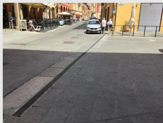
Piazza San Martino – unità urbana priva di segnalazione di attraversamento pedonale
