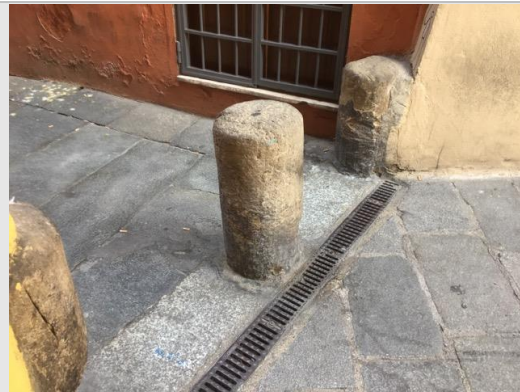
Piazzetta Marco Biagi – elementi dissuasori in pietra che costituiscono ostacolo al passaggio di persone con ausili alla mobilità (deambulatori, carrozzine, ecc.)
