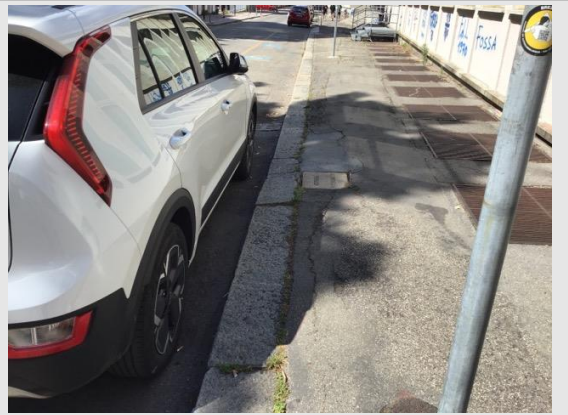
Via Graziano – percorso pedonale con sconnessioni, assenza di raccordi con i parcheggi riservati per persone con disabilità
