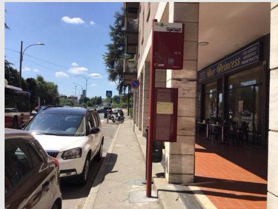
Via della Pietra – palina segnaletica posta su percorso pedonale stretto, privo di raccordi adeguati con il porticato, con pendenza trasversale e posto in corrispondenza di auto in sosta
