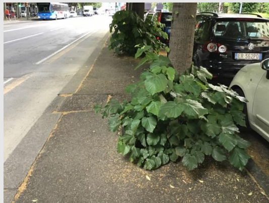
Via Stalingrado – Vegetazione che occupa il percorso pedonale, causando anche sconnessioni della pavimentazione
