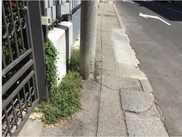
Via della Pietra – pendenza trasversale, passo carraio inadeguato e palo dell'illuminazione posto sul marciapiede
