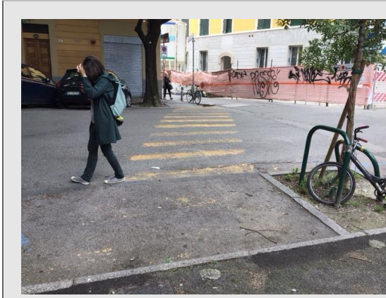
Via Francesco Albani – attraversamento pedonale "provvisorio" inadeguato, vista cantieri
