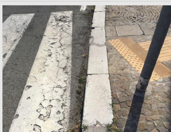
Via Marzabotto – Segnaletica podotattile in massello autobloccante
