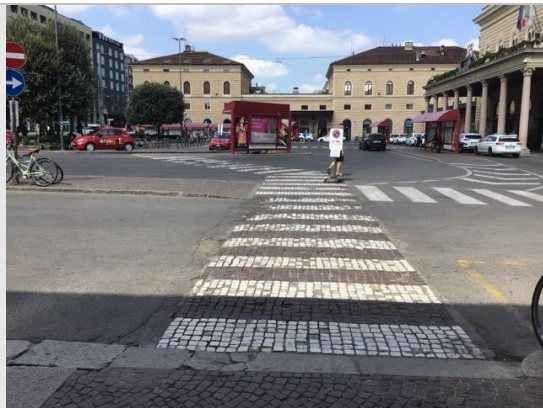
Piazza Medaglie d’Oro – percorsi pedonali ed attraversamenti pedonali sconnessi, privi di segnaletica tattile di orientamento, carenza di wayfinding
