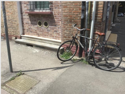
Via Nicolò dall'Arca – Bicicletta che occupa parte del percorso pedonale
