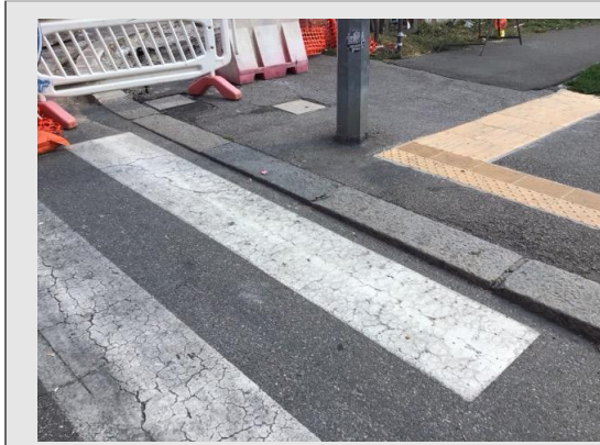
Via del Lavoro/via Ruggero Ruggeri – segnaletica podotattile di orientamento in corrispondenza dell'attraversamento pedonale
