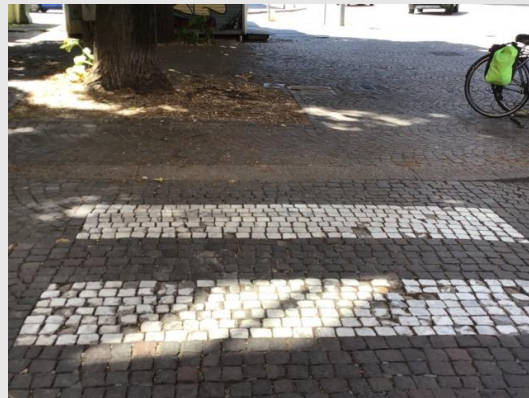
Piazza Manfredi Azzarita – Percorso pedonale posto di fronte ad una alberatura, nessuna linea guida naturale o artificiale di orientamento
