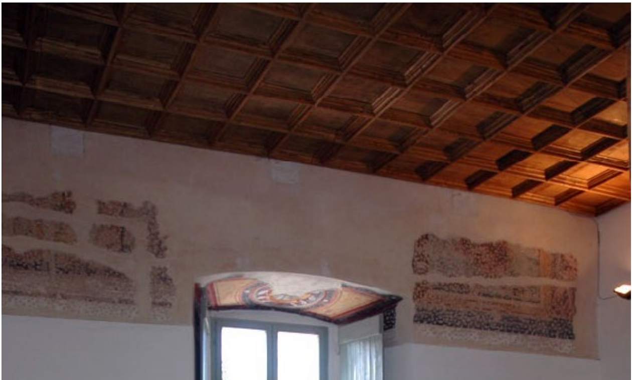
Vista del cassettonato al piano terra
