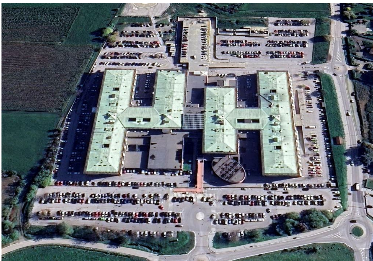
VISTA AEREA DELL'INSEDIAMENTO
